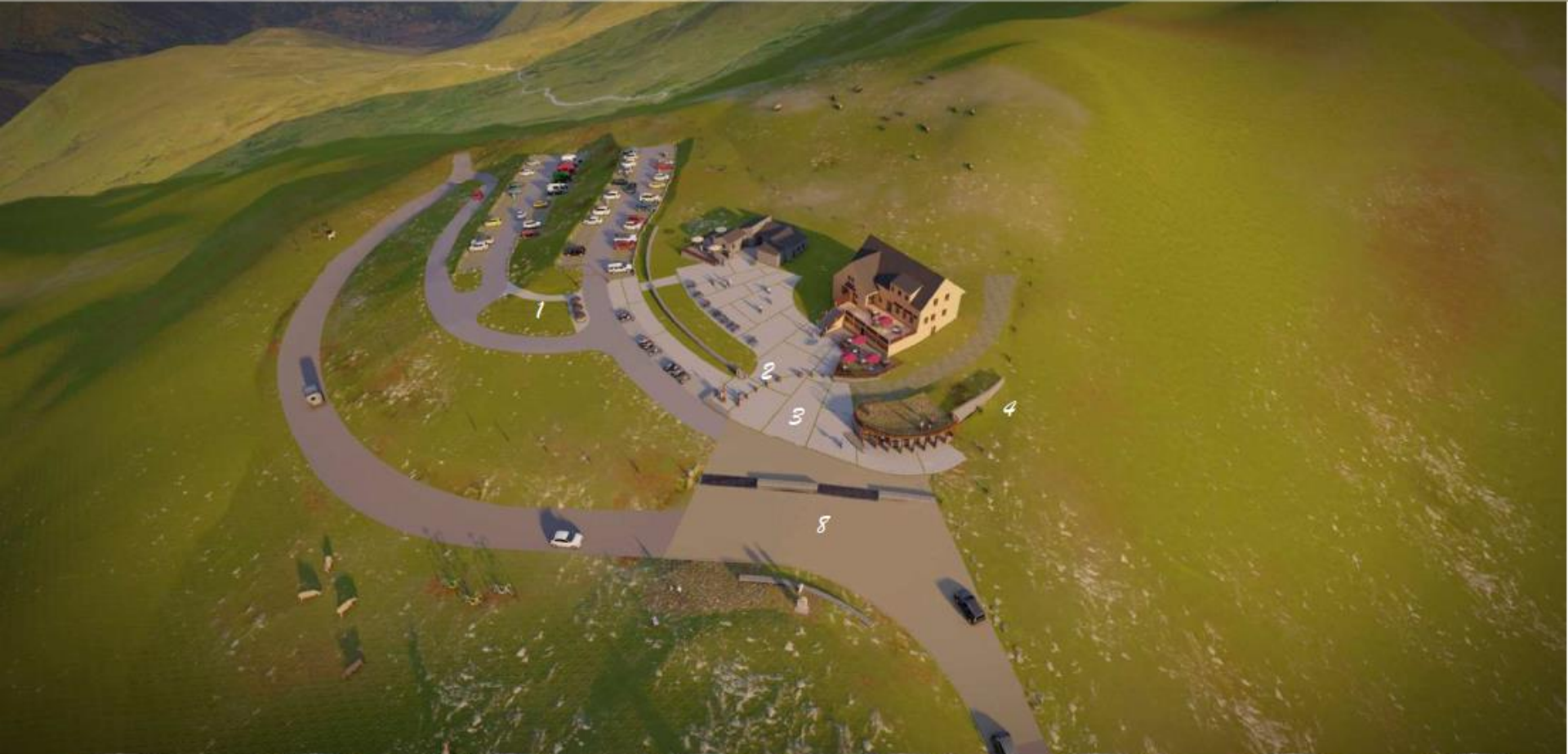
VUE AERIENNE SUD EST [+ Matériaux]
